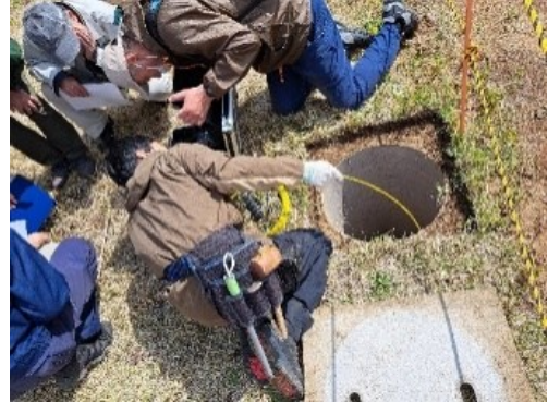
写真1 暗渠配管内の調査状況
