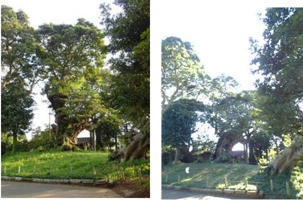
写真5 被害前と被害後の状況
