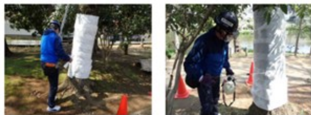
写真 3 施工位置に吸水ペーパーを巻き、これに浸み込むように薬剤散布を行う。（長期効力を維持すると共に、脱出の薬剤付着を期待する。散布時は周囲の人や物を確認し飛散防止に努める。）
