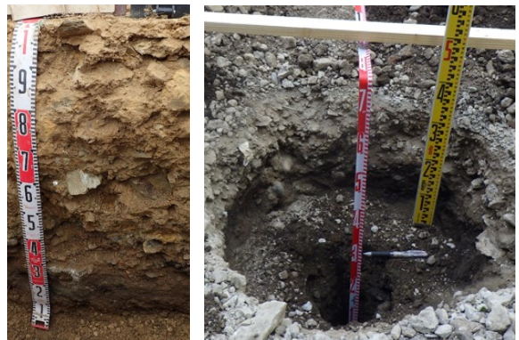
写真. 5 礫含量6割を超える礫土
