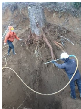
写真 3 エアスコップ掘削 写真 4 最深部根系
