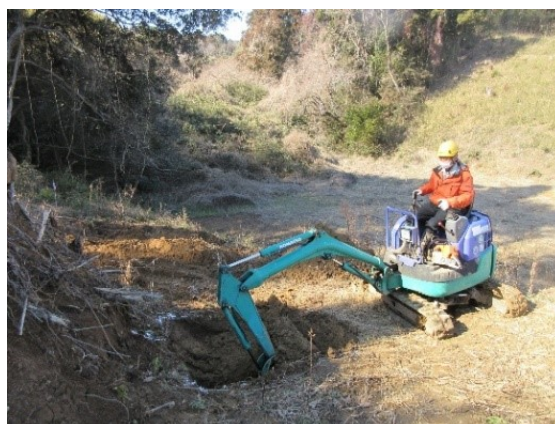
写真 2 バックホウによる掘削
