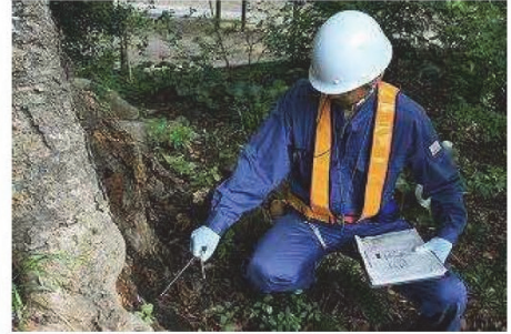
診断：鋼棒貫入
