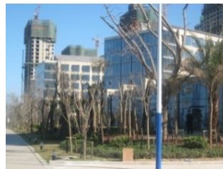
写真6 シェラトンホテル
