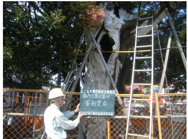
写真5 幹本体処置状況
