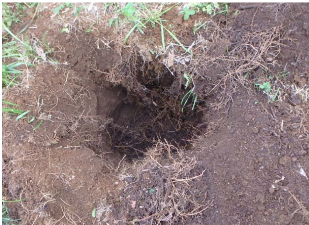
写真 2 空気管の周りを試掘した様子
