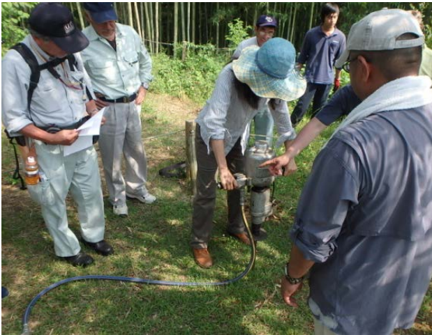
写真 1 ピックエアレーション施工体験風景
