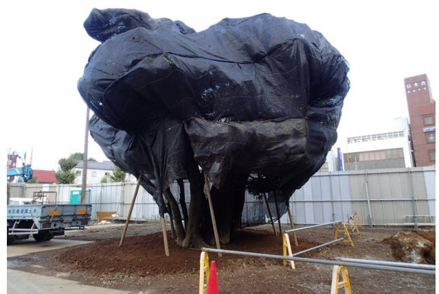
写真 11 移植後寒冷紗設置状況
