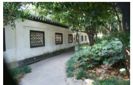
写真4 漏窓のある壁
