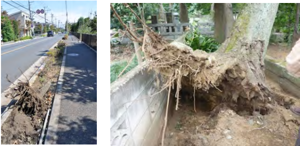
写真 60 根が乏しいナミズキ 写真 61 根元が腐っているシラカシ
