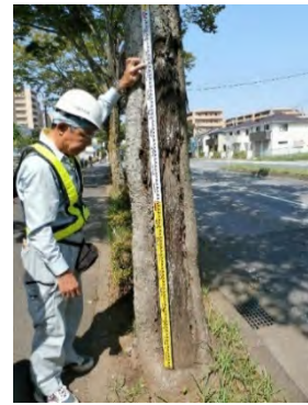
写真9 腐朽部の測定
