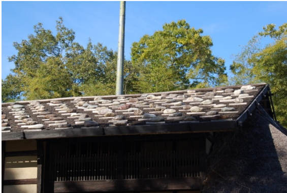
(写真3. 重要文化財旧新井家住宅の屋根) 住居に養蚕の設備がある。栗の板の屋根は秩父では一般的なものだ。
