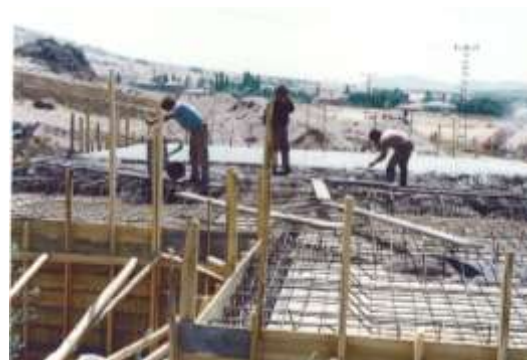
(写真3. 木製型枠)
