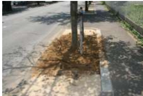
(写真 5. 植栽枡内の土壌改良)
