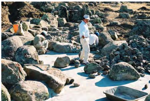
●滝と流れの施工状況 40t クレーン使用 29P
