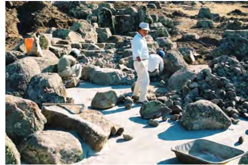
(写真 19. 滝と流れの施工状況 40 トンクレーン使用)
