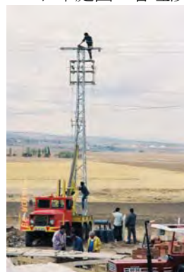
(写真 14. 高圧鉄塔の設置) (図 1. 遺跡井戸より水管設置)
