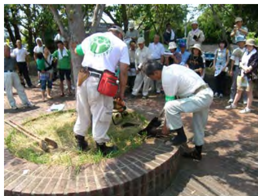
(写真6. 空気管設置作業の実演)
