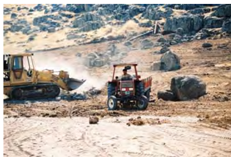
(写真 13. 盛土造成)
