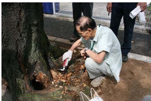
（写真 2.腐朽部除去後の炭化処理）
